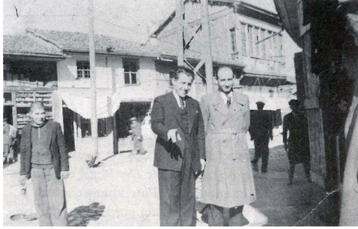
26 ► Tokat çarşısında manifatura dükkânı işleten Garbis Dülgeroğlu ve meslektaş Zaven Kılıçyan (1950’li yıllar).
